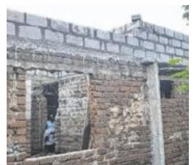
Das Haus soll renoviert werden.
